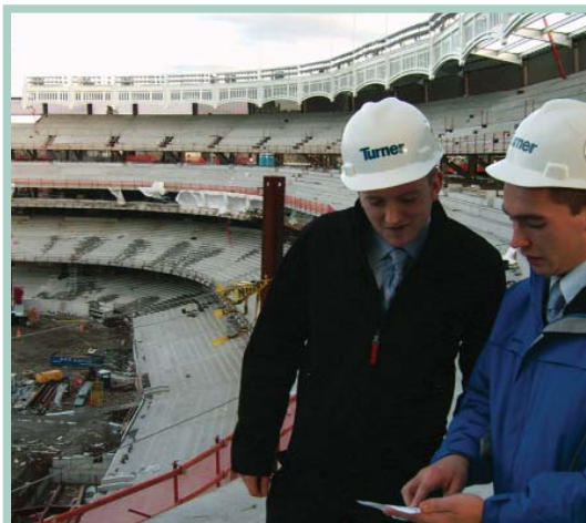
Colin Fagan agus John Doyle, Scoláirí i mBainistiúcht na Foirgníochta, ag obair i Nua-Eabhrach (Yankee Stadium) le Turner Construction
